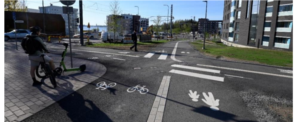
Kuva 7, Kehyskadun liikenneympyrän jalankulun ja pyöräilyn infrastruktuuria. Kulkumuodot on erotettu toisistaan selkeästi betonikiviraidalla ja tiemerkinnoilla.
